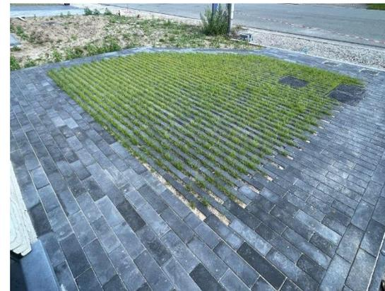
Pavés à joints perméables
