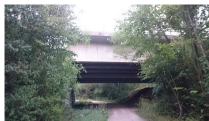
Passage technique sous l'A36 (source : AudaB)
