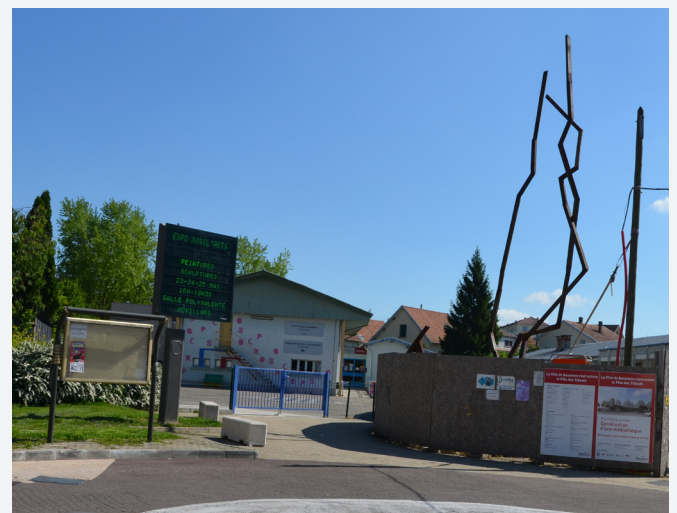
MJC de Palente et médiathèque en construction
