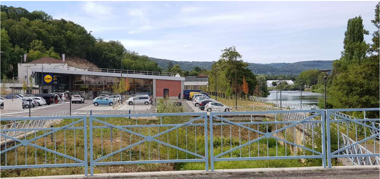
Exemple : SCoT Nord-Doubs. Implantation commerciale sur une friche industrielle. Gestion de l'infiltration des eaux pluviales et transition paysagère avec le Doubs. Crédit ADU - 2020.
