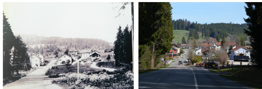
La RD437 (sud de Bonnetage), d'hier à aujourd'hui
