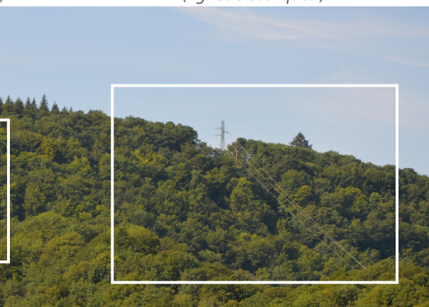
Réseaux (lignes électriques)
