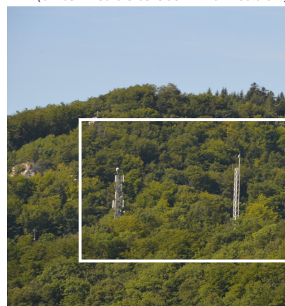
Réseaux (antennes de télécommunication)
